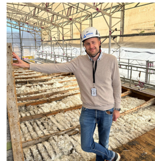
Vår projektledare Martin mitt i takrenoveringen.
