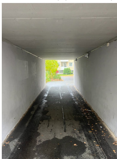
Såhär såg gångtunneln ut innan Mathildas verk.
